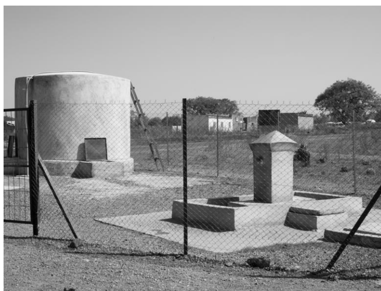
Poste d'eau autonome solaire réalisé par HELVETAS à Faradiélé (Mali). Coût :
