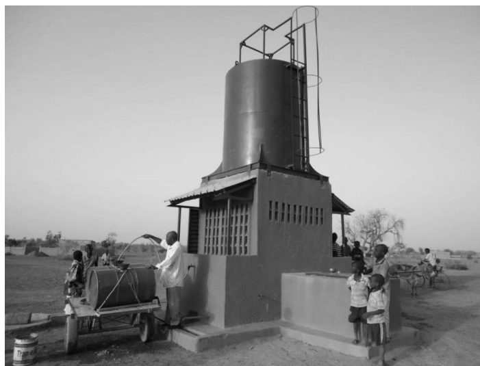
Poste d'eau autonome à la périphérie de Ouahigouya (Burkina Faso). Coût : environ 15 millions F CFA sans le forage.
