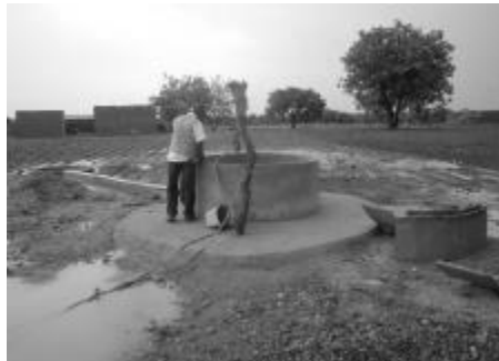
Photo 8 : Nouveau puits réalisé dans le village de Nabitenga
